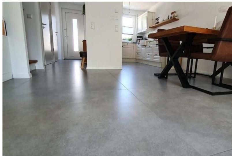
Die großformatigen Fliesen sind aus Feinsteinzeug. Dieses natürliche Material ist absolut robust, denn es ist bei sehr hohen Temperaturen gebrannt worden.
